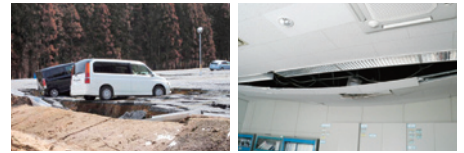
白河事業場の駐車場の液状化 白河事業場の天井板落下
