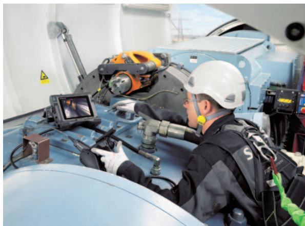
風力発電タービン変速機の検査
