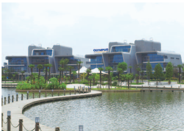
上海トレーニングセンター全景
